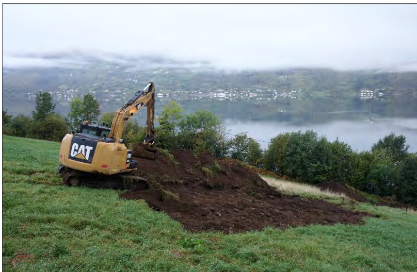
Figur 5. Fjerning av matjord på begge sider av den eksisterende overvannsrøften. Sett mot sørvest.
